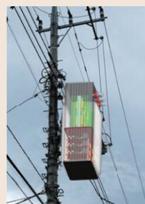
図4 柱上設置STATCOMのイメージ図
